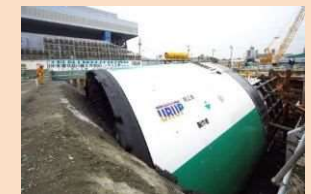
大井地区トンネル(地上発進) 出典: 大林組技術研究所HP
