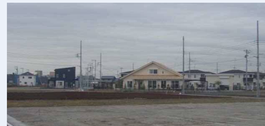
住宅建築が進む埼玉スタジアム周辺
