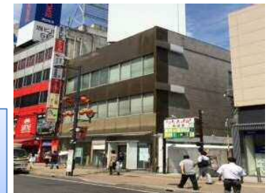
設置場所 外観 (現況)
