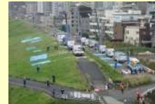
排水ポンプ車の設置
