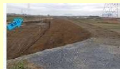
(出典)関東地方整備局HP 鬼怒川右岸山王中流築堤工事施工状況 (2020年12月11日時点)
