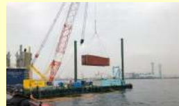
海底障害物の撤去
