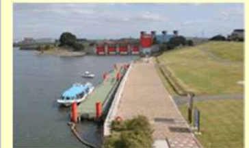
（出典）関東地方整備局HP
