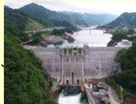
(出典)関東地方整備局HP
