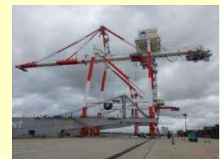
<ガントリークレーン6号機を岸壁上のレールにセットしている様子>
