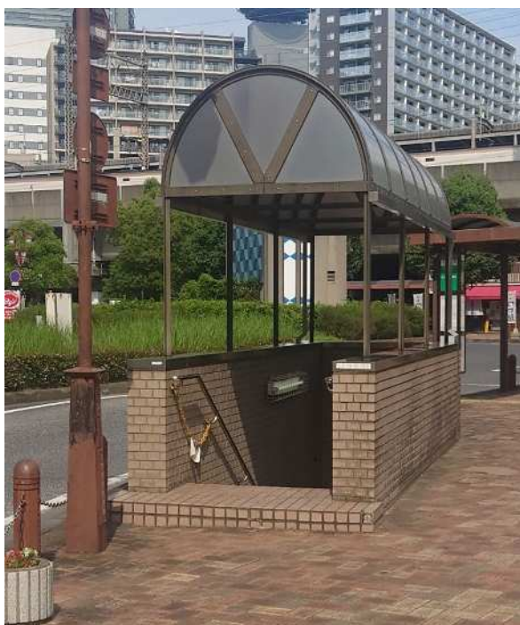
【駐車場利用者出入口階段（西側）】
