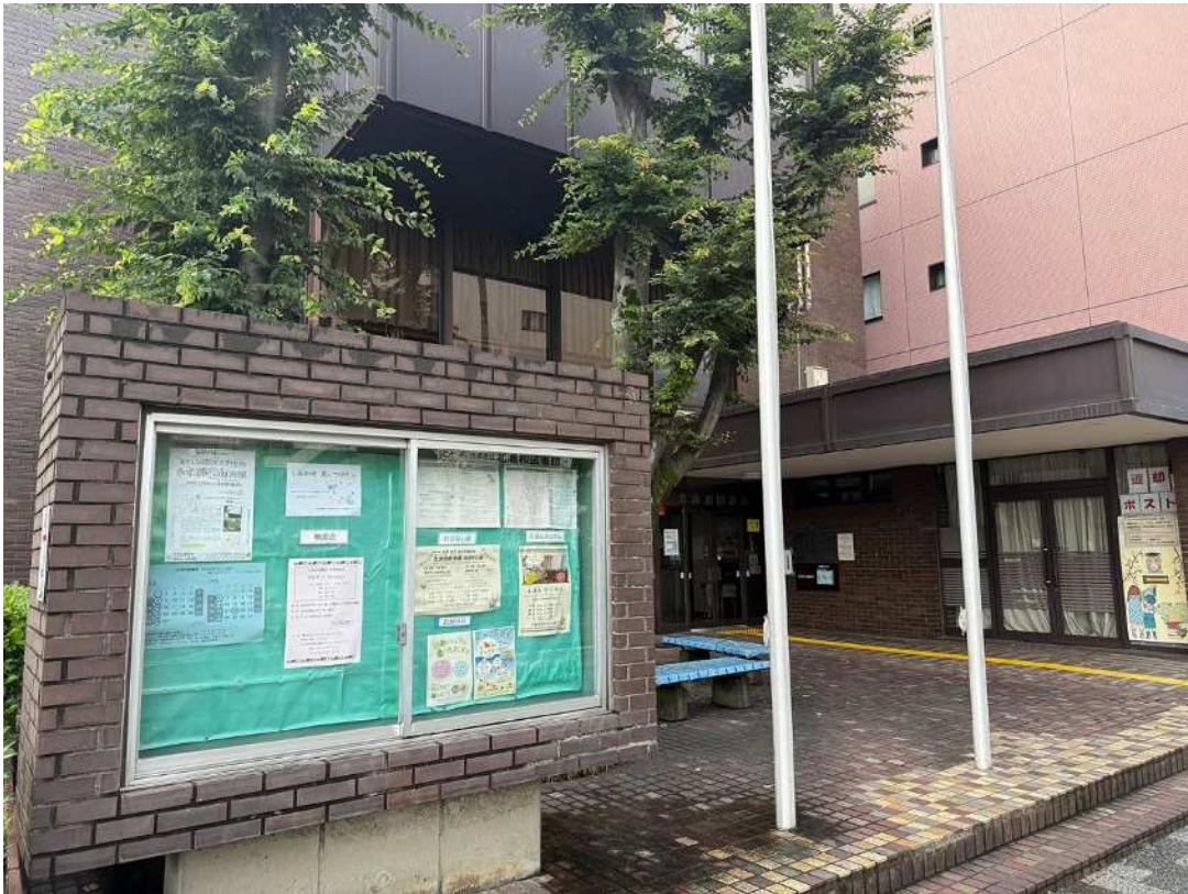
【施設外観写真】
