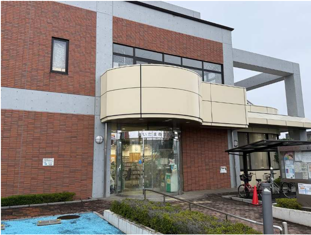
【施設外観写真】
