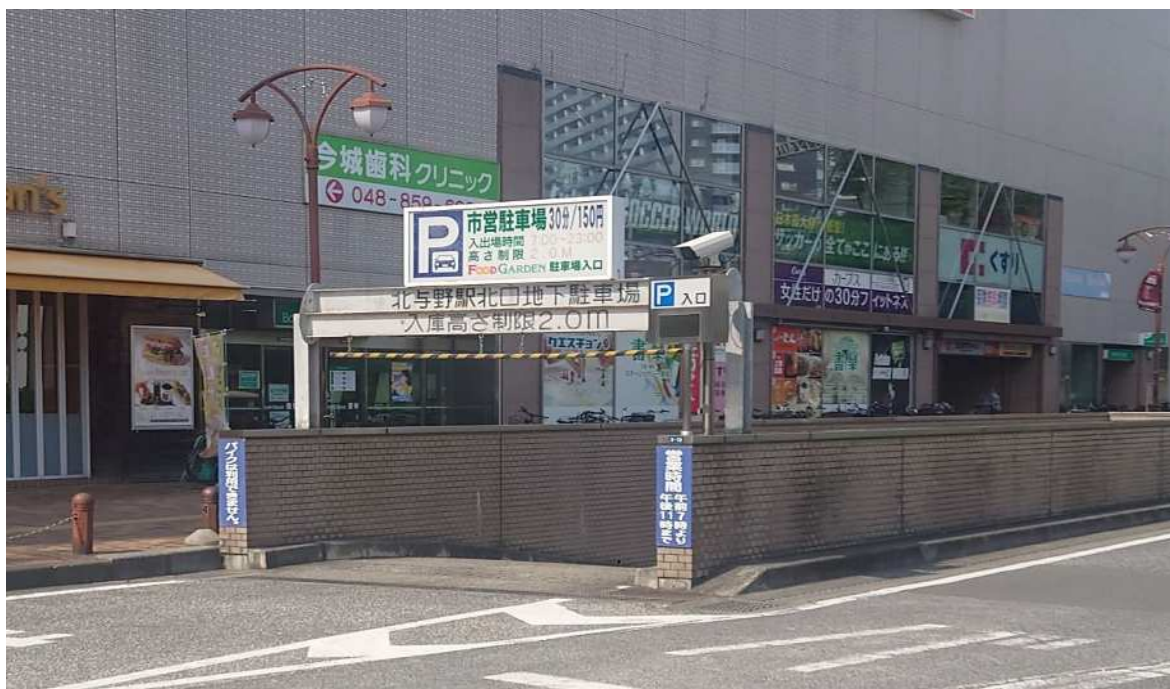
【駐車場車両入口】
