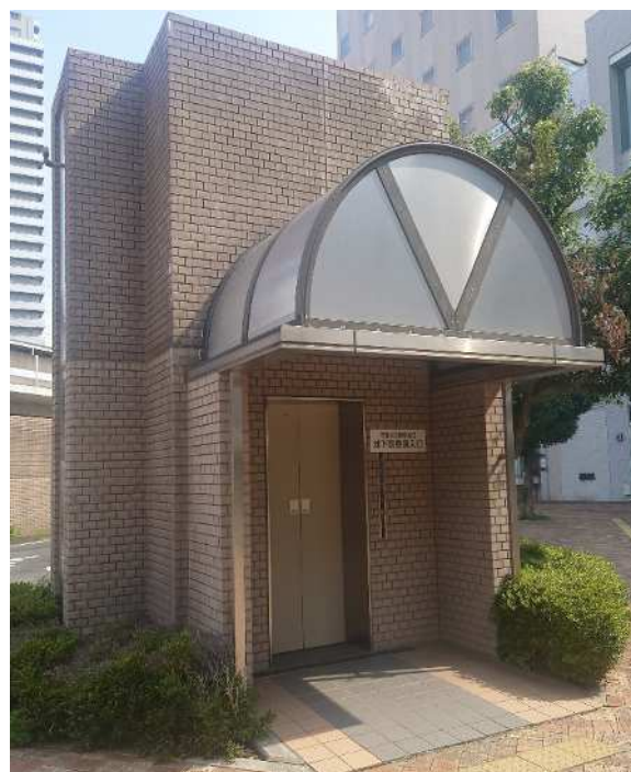
【駐車場利用者出入口EV】
