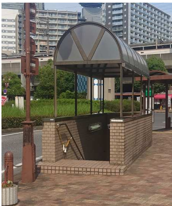
【駐車場利用者出入口階段（西側）】
