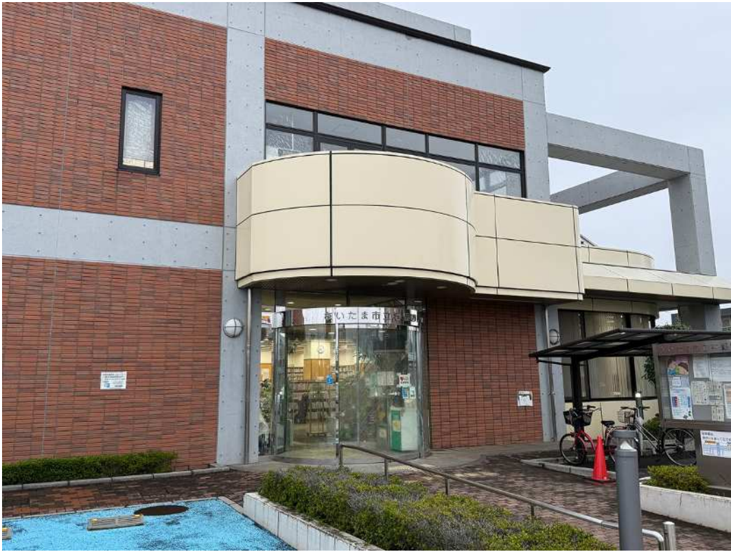
【施設外観写真】
