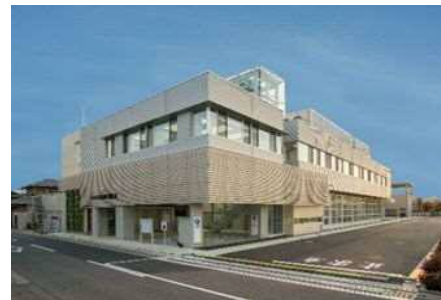
見沼消防署完成写真
