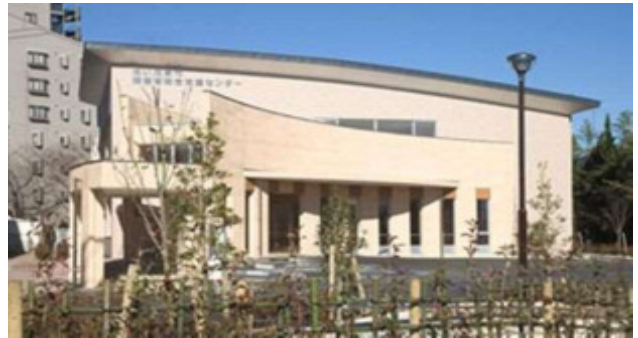
障害者総合支援センター
