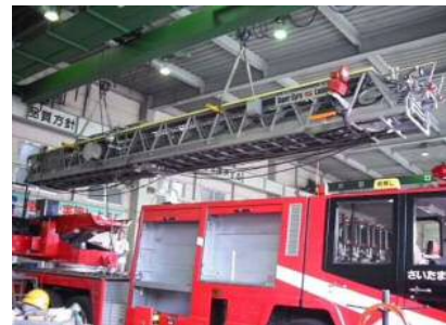
はしご車のオーバーホール状況
