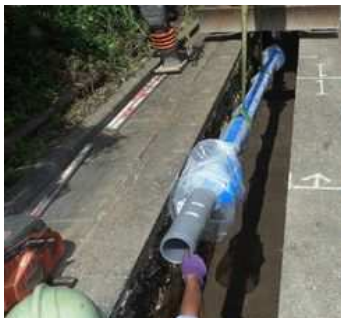
老朽管更新工事
