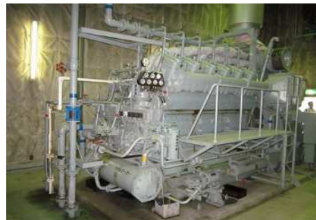
自家発電設備更新工事
