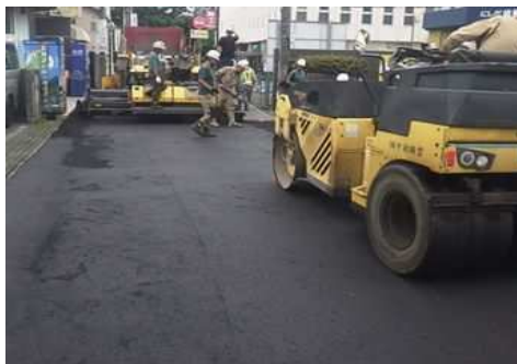
土木緊急修繕等事業
