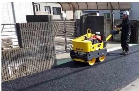
道路の緊急修繕
