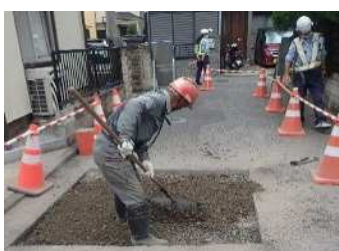
【道路緊急修繕】
