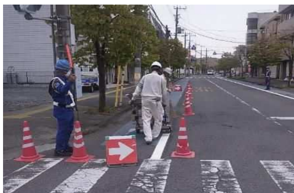
交通安全施設の修繕
