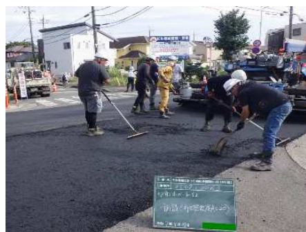
土木緊急修繕等事業
