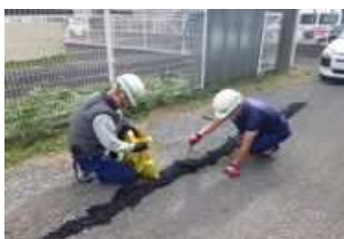
土木緊急修繕の様子
