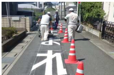
路面表示修繕の様子
