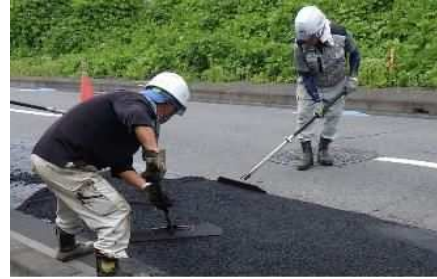
土木修繕工事
