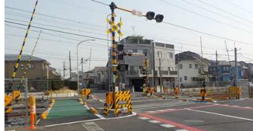
踏切改良（歩道拡幅）事例
