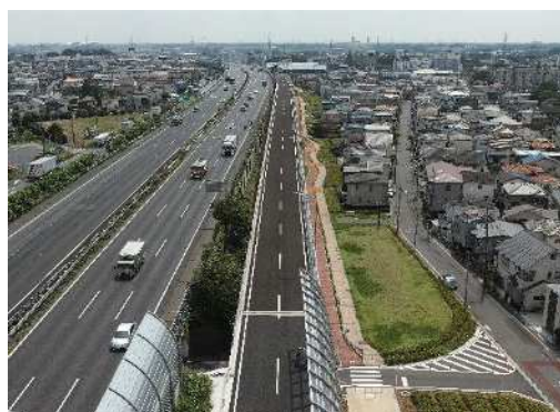
一般国道122号蓮田岩槻バイパスの整備状況 (加倉(北)交差点～平林寺橋交差点) [令和7年3月 4車線開通]
