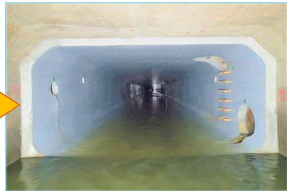
管更生により改築した下水道管
