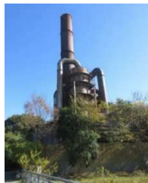
【解体工事の対象施設】
