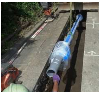
老朽管更新工事
