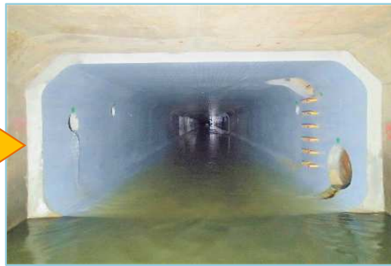
管更生により改築した下水道管
