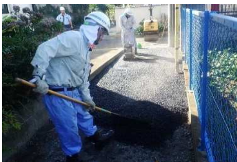
土木緊急修繕等事業
