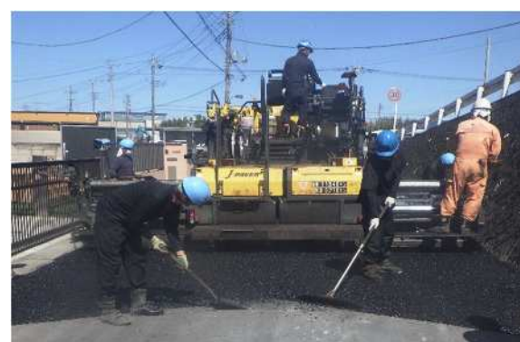
道路の緊急修繕
