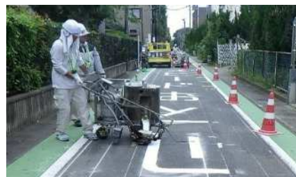
路面表示修繕の様子
