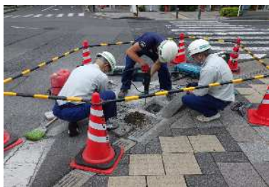
土木緊急修繕の様子
