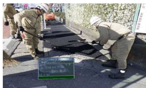
土木緊急修繕等事業
