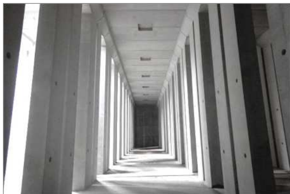
下水道浸水対策（雨水貯留施設）
