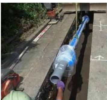
老朽管更新工事
