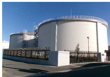
北部配水場更新工事
