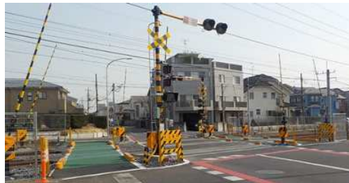
踏切改良（歩道拡幅）事例
