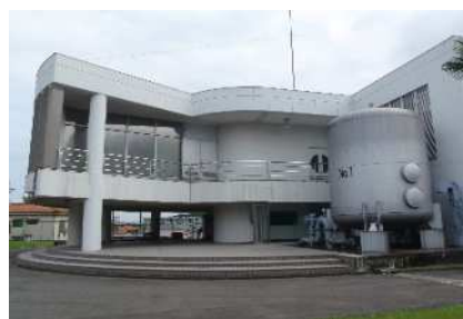
オンサイトPPA （尾間木配水場ほか2機場）
