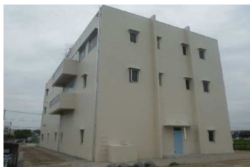
北部配水場更新工事
