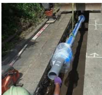
老朽管更新工事
