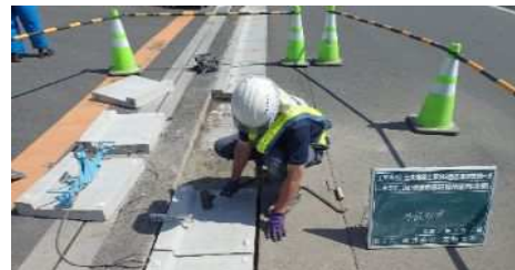
土木緊急修繕事業
