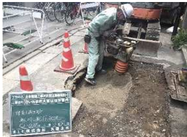
土木緊急修繕の様子
