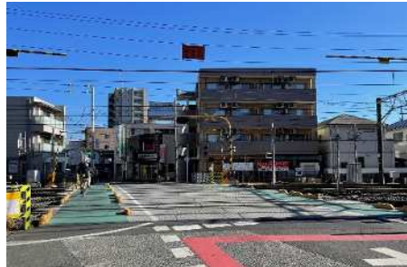
踏切改良(歩道拡幅)事例 (宮原三丁目踏切)
