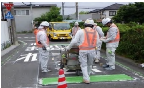
交通安全施設の修繕
