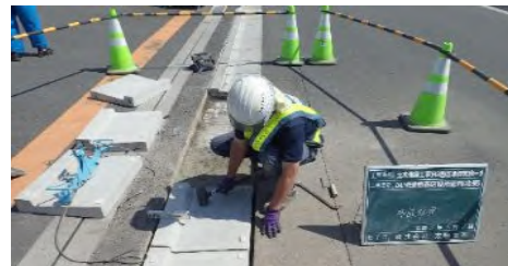
土木緊急修繕事業
