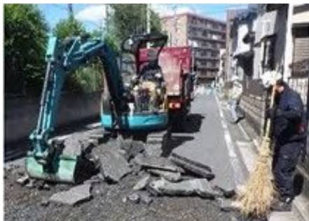
道路緊急修繕
