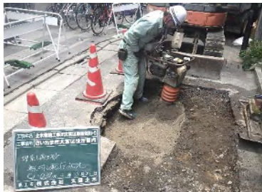
土木緊急修繕の様子
