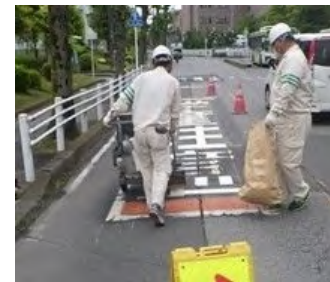
路面表示修繕
