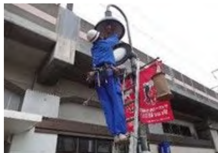
交通安全施設修繕
