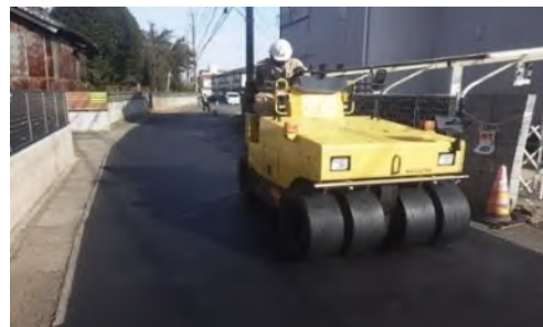
道路の緊急修繕
