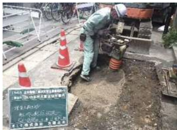
土木緊急修繕の様子
