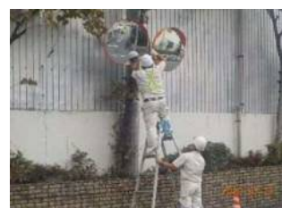
【交通安全施設修繕】
