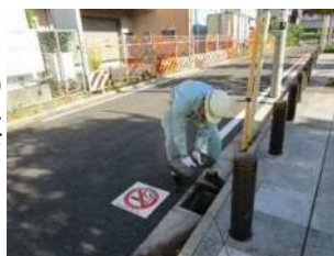
【道路緊急修繕】
