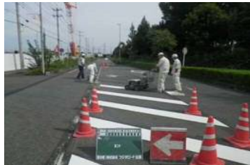
路面表示修繕
