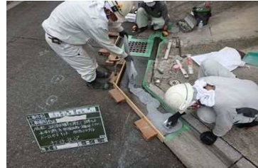
土木緊急修繕
