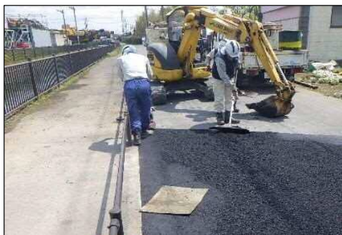
道路の緊急修繕
