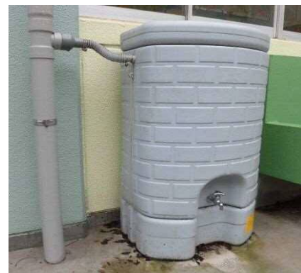
【学校に設置された雨水貯留タンク】
