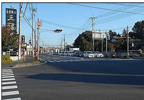
第二産業道路（大和田工区） 拡幅整備
