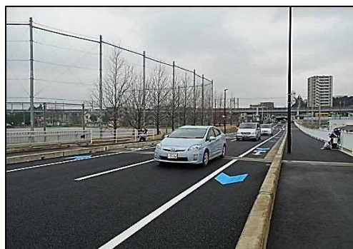
町谷本太線（鴻沼工区） 新設整備
