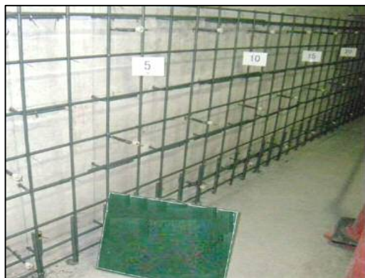
ポンプ場の耐震化（壁の補強状況）
