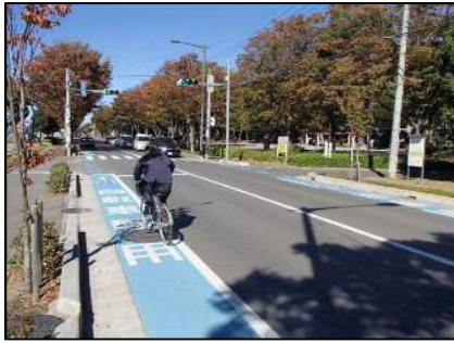
自転車専用通行帯の整備事例(与野中央通り)
