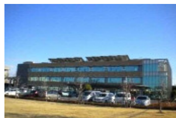
緑区役所庁舎
