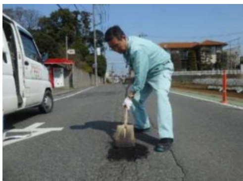
土木緊急修繕
