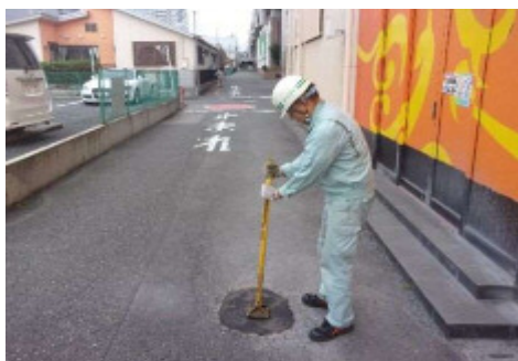
【道路緊急修繕】
