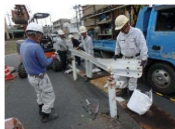
土木緊急修繕
