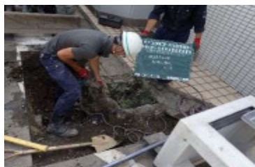
土木緊急修繕の様子
