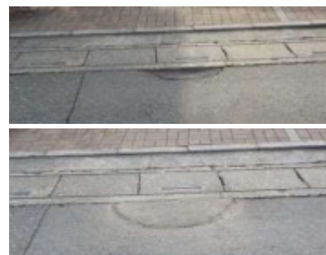
道路緊急修繕
