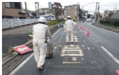
交通安全施設修繕
