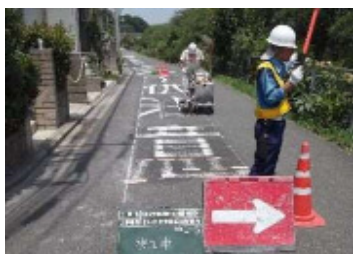
路面表示修繕
