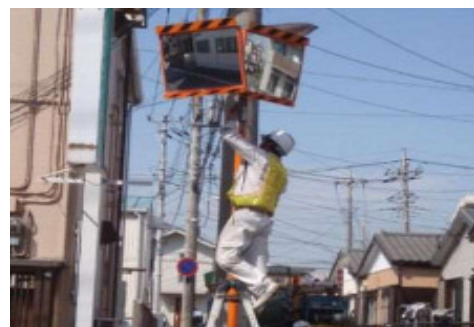
【交通安全施設修繕】
