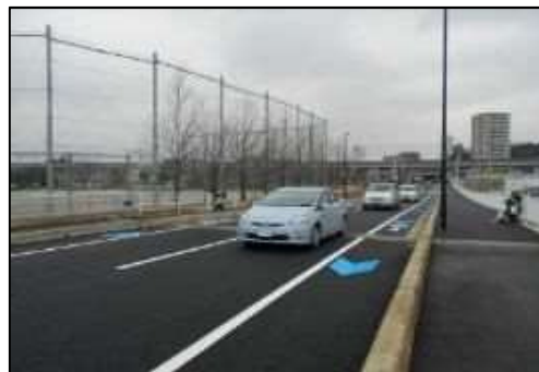
町谷本太線（鴻沼工区） 新設整備
