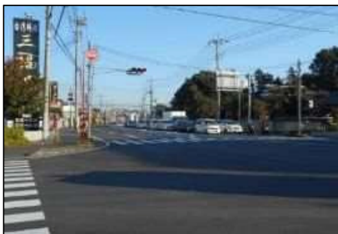
第二産業道路（大和田工区） 拡幅整備
