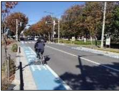
自転車専用通行帯の整備事例(与野中央通り)
