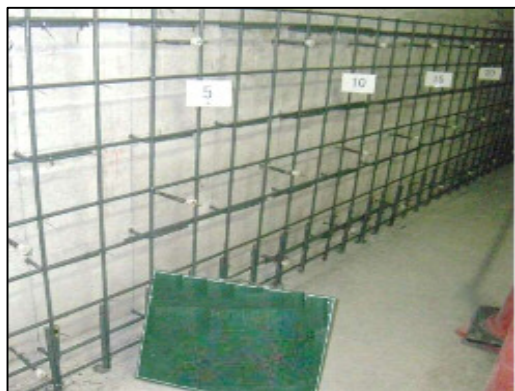
ポンプ場の耐震化（壁の補強状況）
