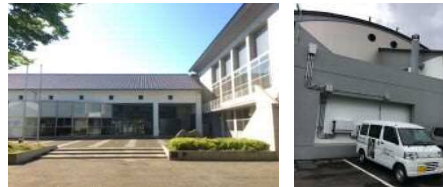
ふれあいプラザいわつき （太陽光による蓄電・VtoX機能付充電）
