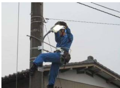
【道路照明灯の修繕】
