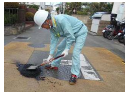
【道路緊急修繕】
