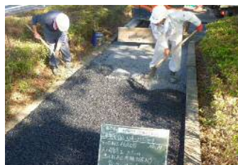
土木緊急修繕
