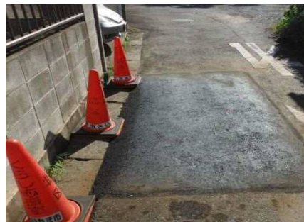
道路緊急修繕
