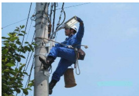
【道路照明灯の修繕】
