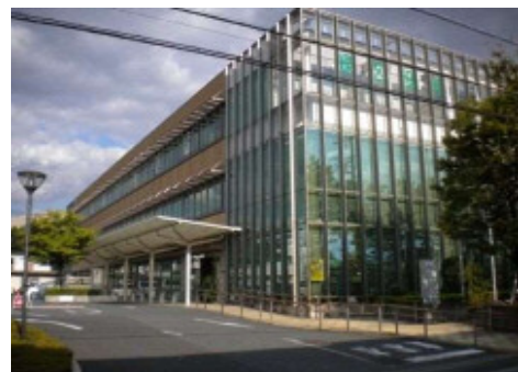
緑区役所庁舎
