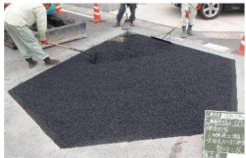
土木緊急修繕
