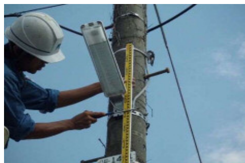
街路灯の修繕
