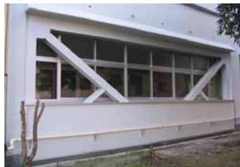
耐震化が図られた校舎[大宮北高校]
