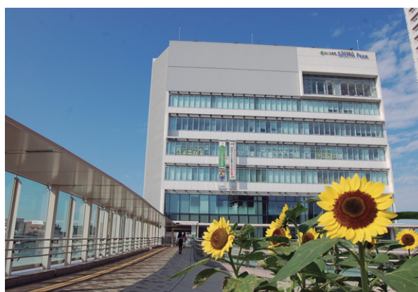
武蔵浦和駅西口「複合公益施設サウスピア」
