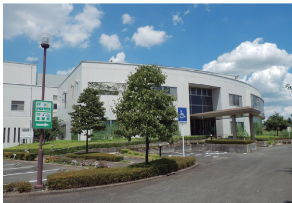
大宮南部浄化センター
