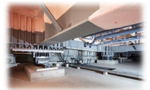
▲参考事例 地下免震装置 (越谷市役所) 出典：越谷市ホームページ
