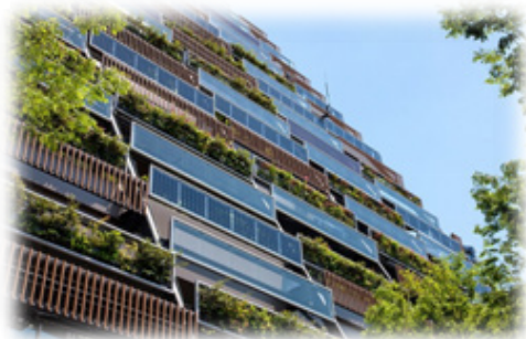
▲参考事例 太陽光パネルの壁面利用 (豊島区役所) 出典：豊島区ホームページ
