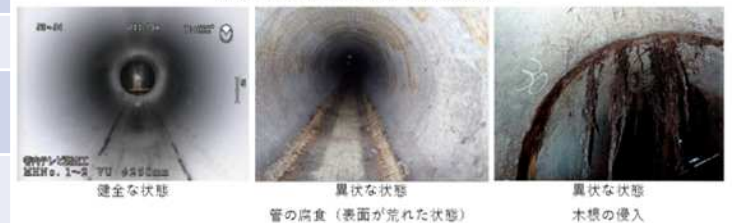
【管きょ内TVカメラ調査（調査状況）】
