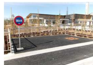
開発行為で設置された耐震性防火水槽
