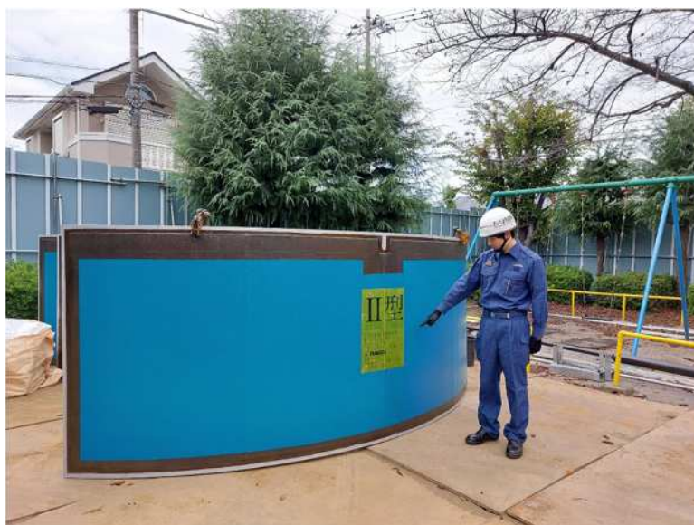
耐震性防火水槽設置工事60m 3 型 (R6)
