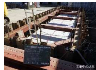
消防局で整備工事中の耐震性防火水槽
