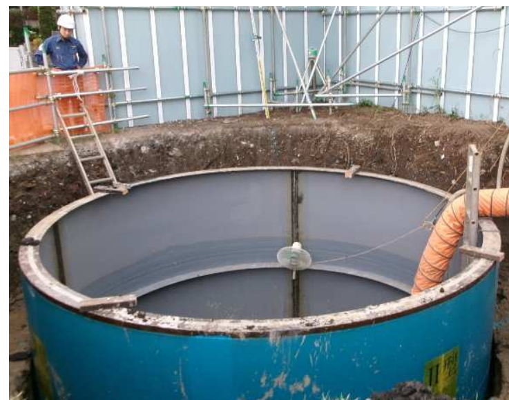
耐震性防火水槽設置工事40m 3 型 (R5)
