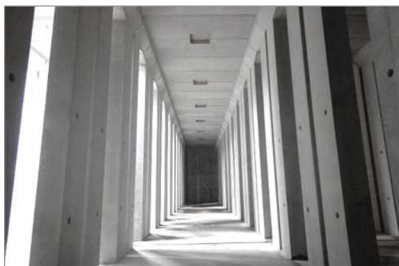
下水道浸水対策（雨水貯留施設）
