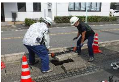
土木緊急修繕の様子
