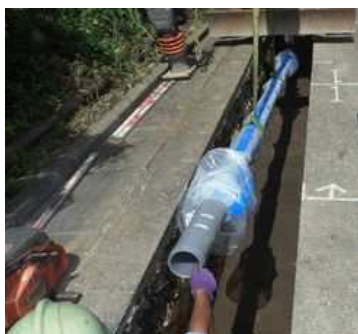
老朽管更新工事
