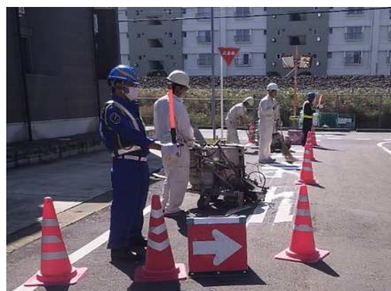
交通安全施設の修繕
