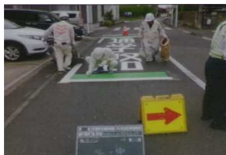
路面表示修繕
