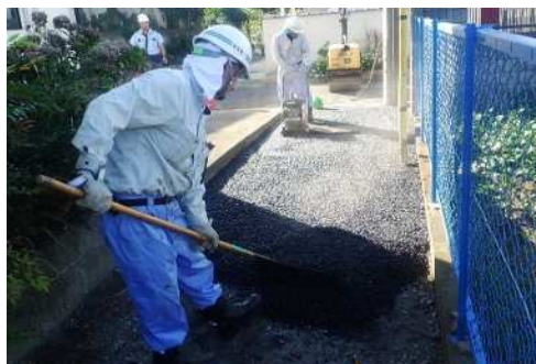
土木緊急修繕等事業
