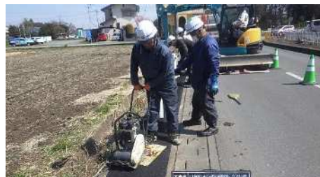
土木緊急修繕等事業
