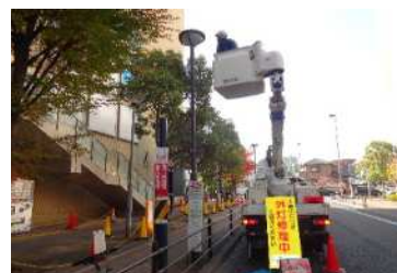
【交通安全施設修繕】
