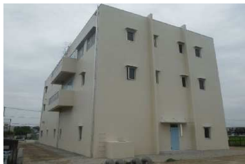
北部配水場更新工事
