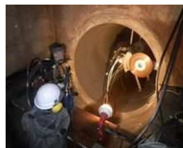
下水道管とマンホールの 継手部耐震化
