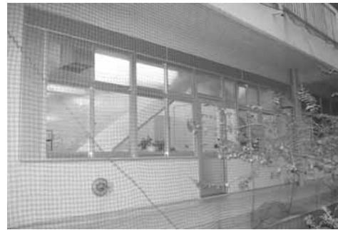
耐震化が図られた建物【桜木中学校】
