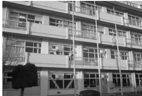
耐震化が図られた建物【文蔵小学校】
