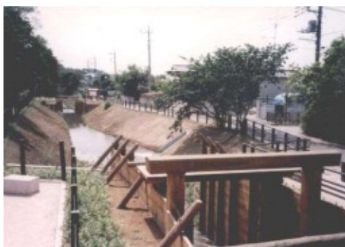
あるべき姿 (平成7年度 整備工事竣工後)
