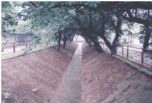
あるべき姿 (平成7年度 整備工事竣工後)
