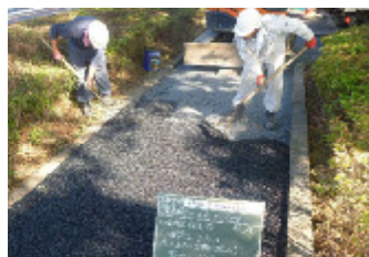
土木緊急修繕
