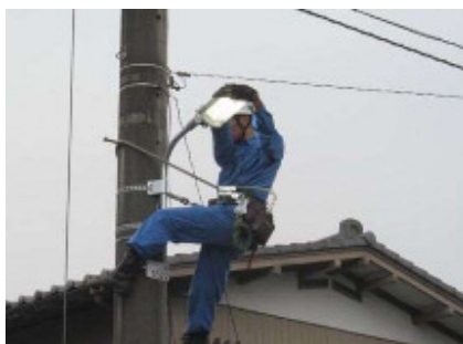
【道路照明灯の修繕】
