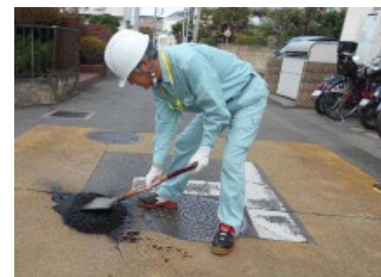
【道路緊急修繕】
