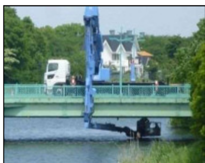
橋りょう点検車による点検
