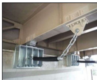
落橋防止装置の取付
