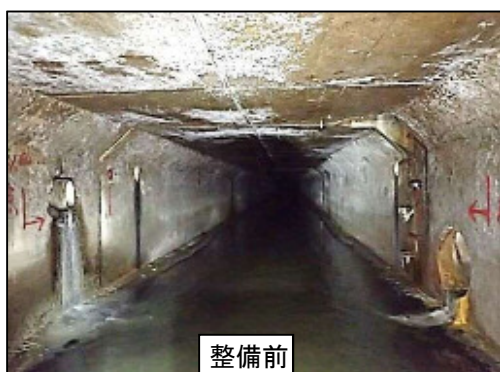
老朽化対策（管きよ更生工法）[南浦和幹線]
