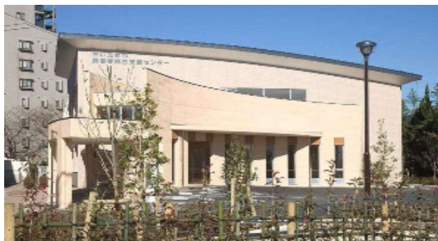
障害者総合支援センター
