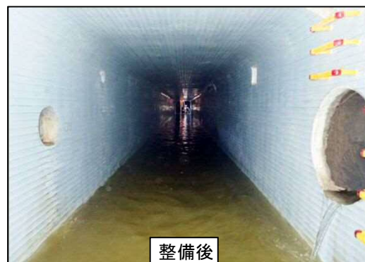
老朽化対策（管きょ更生工法）[別所幹線]
