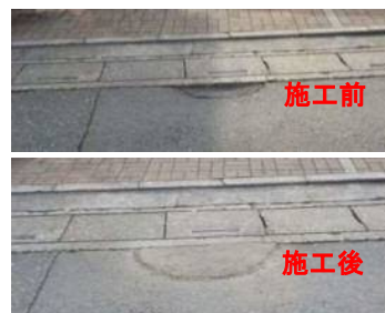
道路緊急修繕
