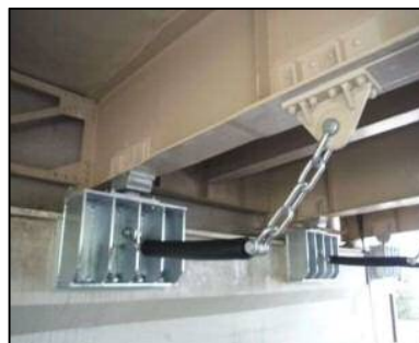
落橋防止装置の取付
