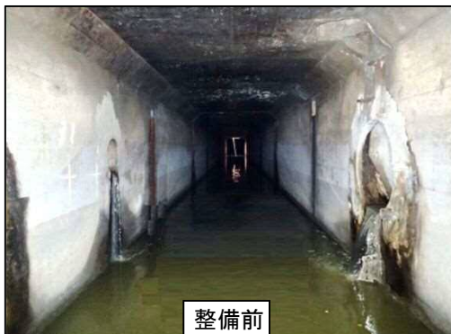
老朽化対策（管きょ更生工法）[別所幹線]
