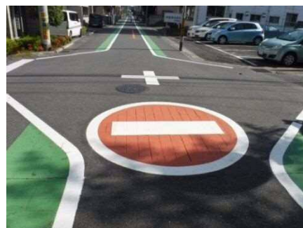
路面表示修繕後の様子
