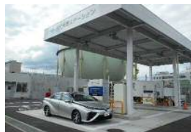
浦和水素ステーション （都市ガスによる水素製造・天然ガススタンド併設）
